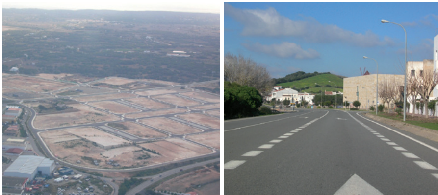
Figura 3. Obres d'ampliació del polígon industrial de Maó (Foto: GOB Menorca)
