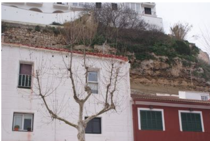
Figura 21. La proximidad a los edificios provoca podas excesivas.
